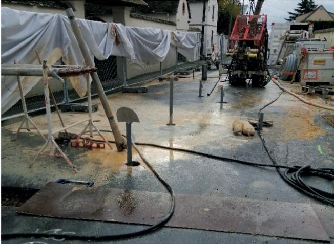
Réalisation des forages et mise en œuvre des fourreaux d'injection
