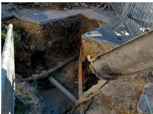
Remplissage cavité avec un coulis de ciment
