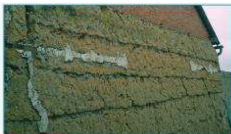
Mur en bauge. Broué.
