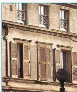
Enduit plâtre et chaux sur une ossature en pan de bois. Châteauneuf-en-Thymerais.
