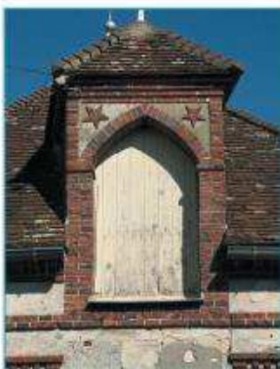
Lucarne engagée dans le mur (dite pendante), maçonnée, à croupe.
