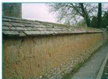
Mur en terre crue, soubassement silex. Broué.
