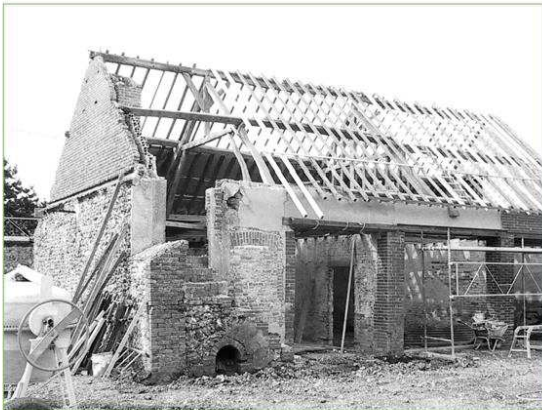
Au dessus : la grange en cours de travaux de rénovation, au printemps 2005.
