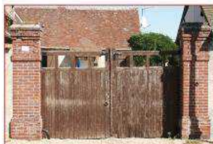
Portail avec piliers en brique, Tremblay-les-Villages
