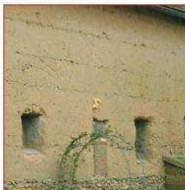
Mur de ferme et en haut à droite mur de clôture en bauge.
