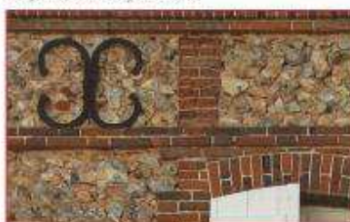
Maçonnerie de brique et silex
