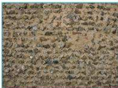
Le soubassement des murs en bauge : ragnons de silex et mortier de terre crue. Laons
