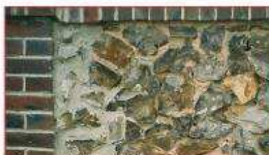
Maçonnerie de brique et silex
