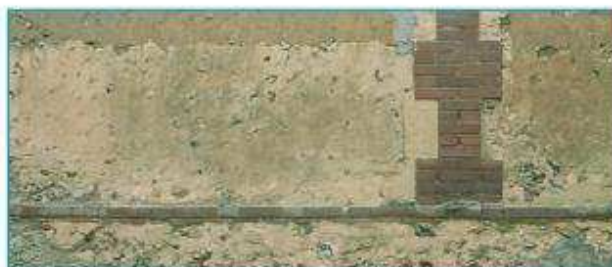
Mur en bauge recouvert d'un badgeon de chaux. Broué.
