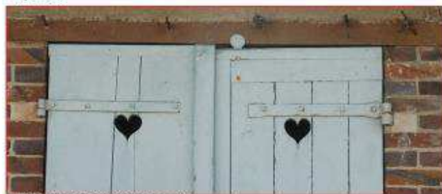
Jour de ventilation en forme de cœur
