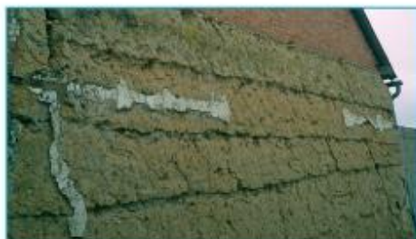
Mur en bauge. Broué.
