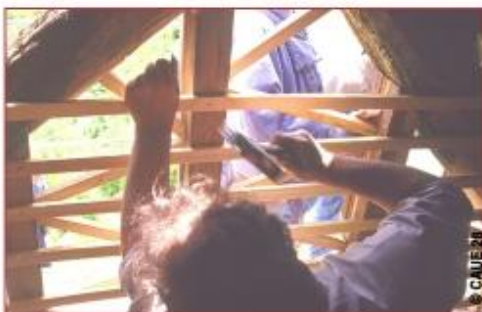
Chantier de restauration d'un mur en torchis. Au dessus, réparation de la structure secondaire à édisse et barreaudage. En dessous, application du torchis sur la structure secondaire avant de remplir les "vides" intersticiels.
