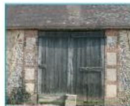
Tuiles en terre cuite, silex, bauge, briques en terre cuite, hêtre pour la porte de la grange. Saint-Jean de Rebervilleis.
