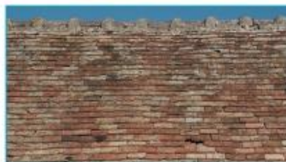
Le faitage des toitures en tuile
