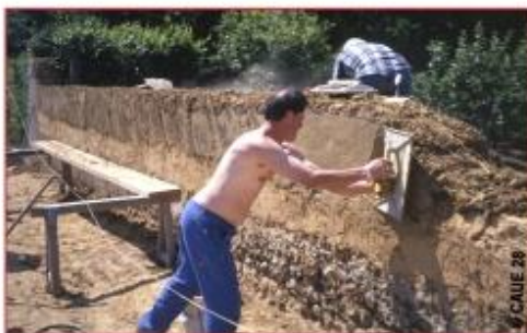
Chantier de reconstitution d'un mur en bauge. Au dessus, talochage de la deuxième levée. En dessous, préparation pour la mise en oeuvre d'une levée supplémentaire.
