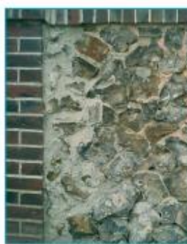
Mur en silex et chaîne en brique.
