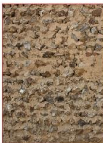
Maçonnerie de silex
