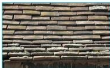
Toit à débordant en tuile
