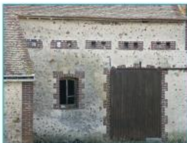
Pignons de silex enduits à pierre vue. Saint-Ange et Torçay.
