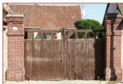
Portail avec piliers en brique. Tremblay-les-Villages
