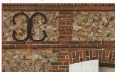
Maçonnerie de brique et silex
