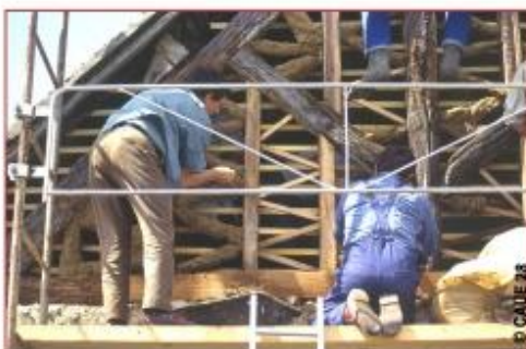
Chantier de restauration d'un mur en torchis. Au dessus, réparation de la structure secondaire à édisse et barreaudage. En dessous, application du torchis sur la structure secondaire avant de remplir les "vides" intersticiels.
