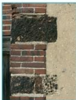
Maçonnerie en pierre de grison et brique.
